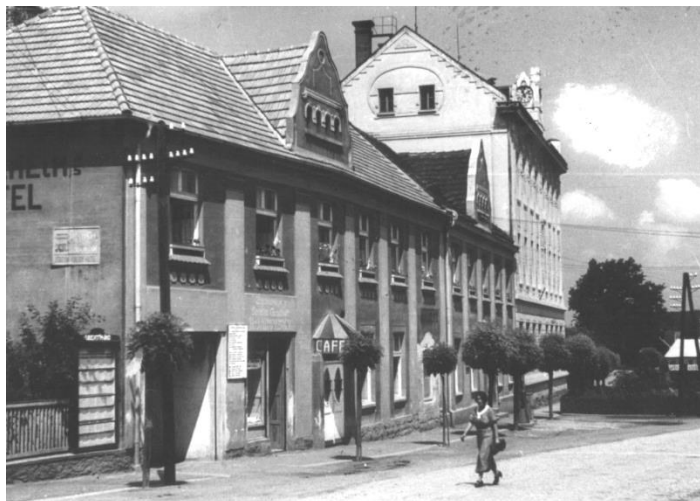
Podoba budovy školy mezi dvěma světovými válkami.
