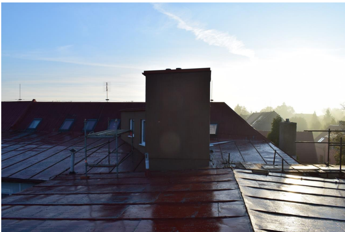
výtahová šachta na střeše budovy školy zalitá podzimním sluncem.
